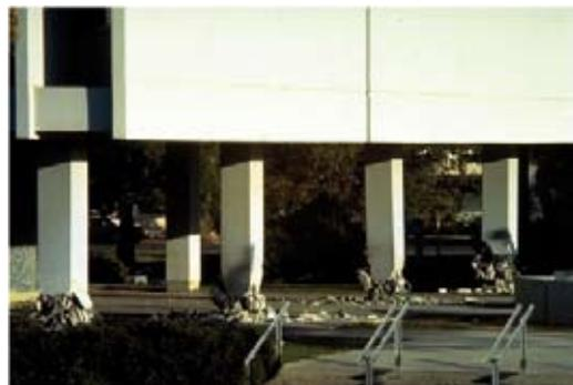
Nel corso della modellazione, quindi, sono state associate diverse cerniere plastiche ad ogni elemento del modello: in particolare, ai pilastri sono state assegnate due cerniere a taglio (descrivono
