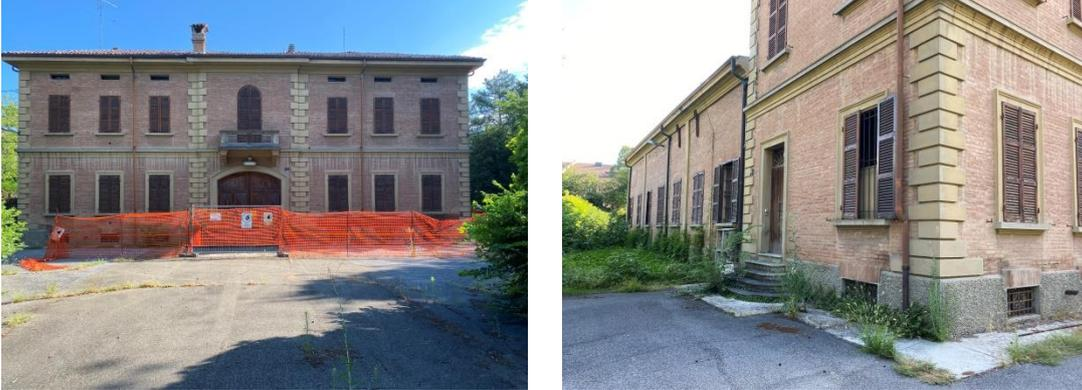
La costruzione comprendente la palazzina e i retrostanti capannoni è stata realizzata agli inizi del secolo trascorso, in una unica soluzione e in continuità strutturale; probabili interventi successivi, hanno portato alla realizzazione di un livello rilevato nei capannoni con sovrastanti suddivisioni murarie, alterando la buona simmetria dei setti presenti nella costruzione iniziale.
