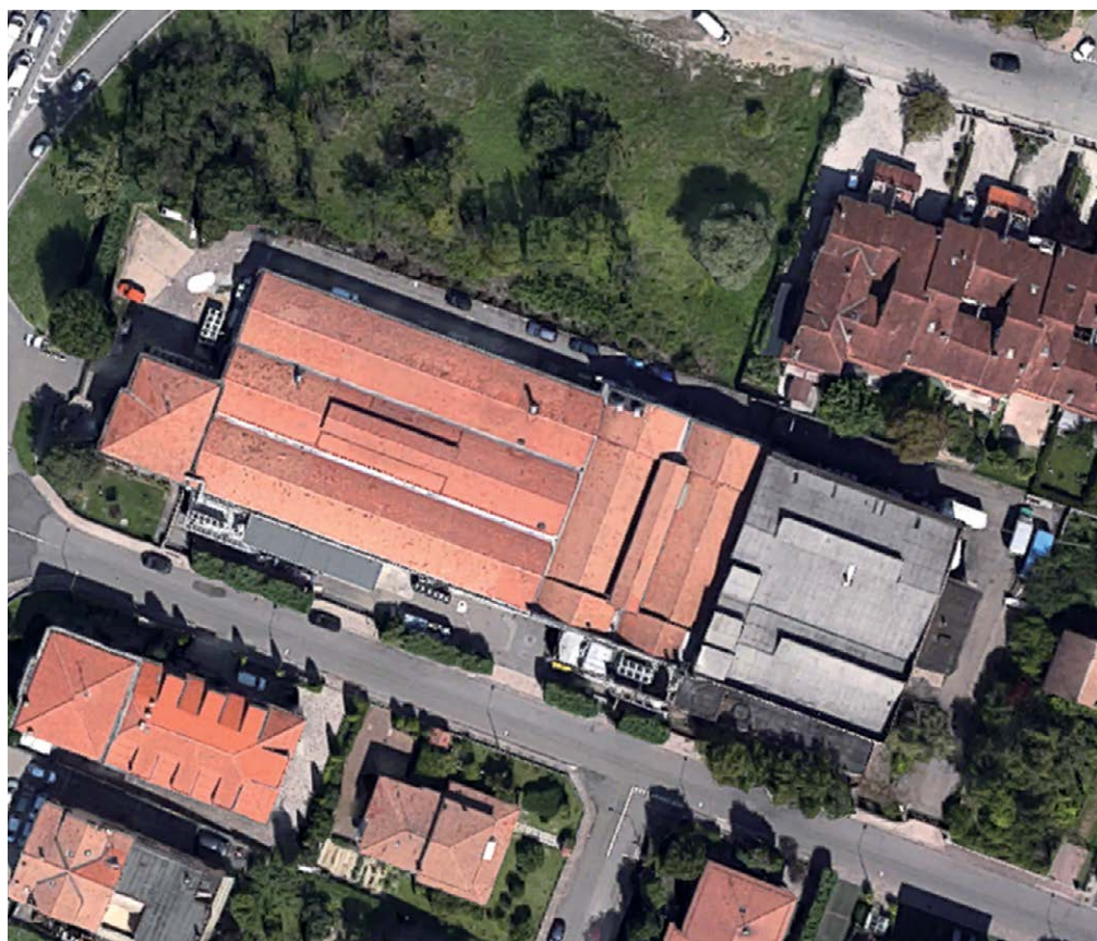
Figura 1 Vista aerea della promiscuità dell'impianto produttivo con le abitazioni limitrofe.
