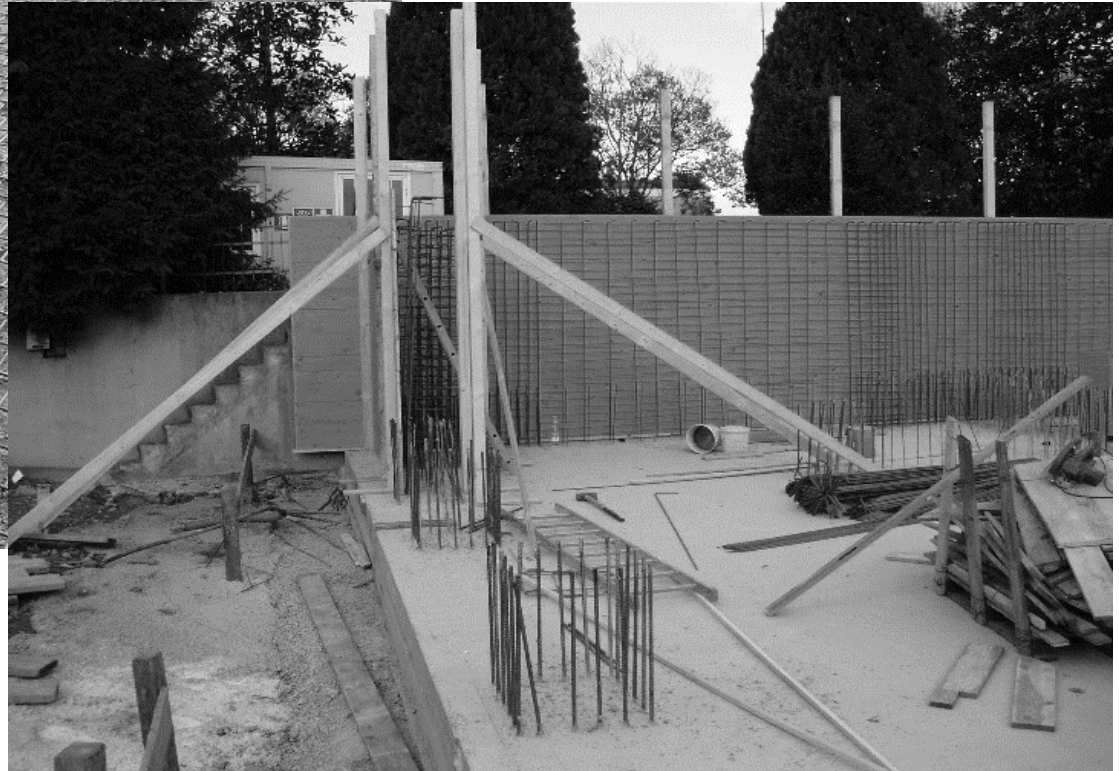
Muri di cantina
