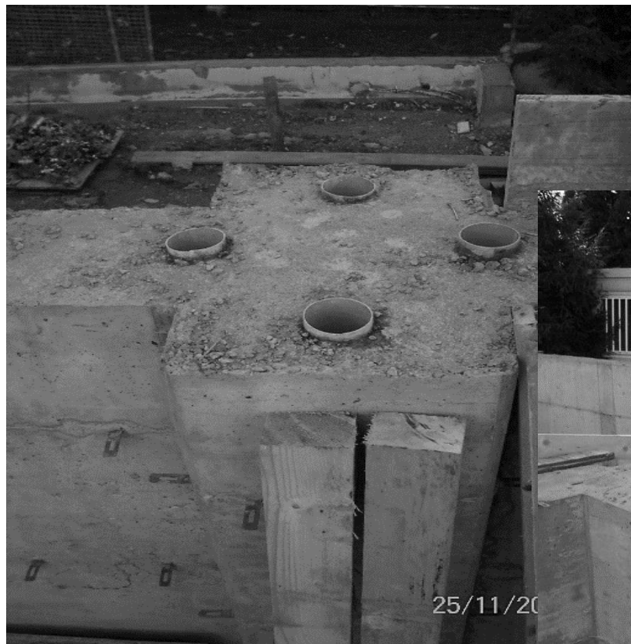
fori per l'ancoraggio degli isolatori
