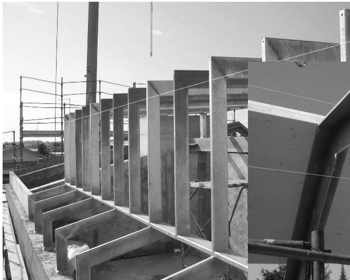
loggia di copertura prodotta in officina e connessa in opera
