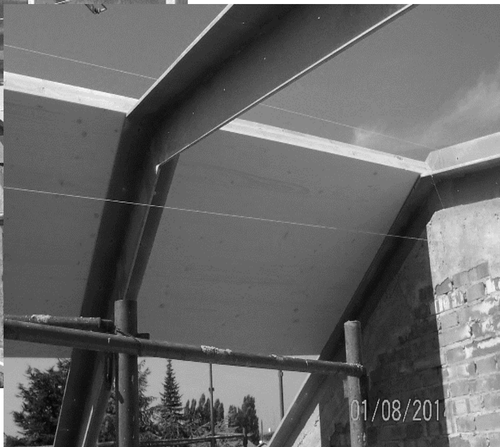
loggia di copertura prodotta in officina e connessa in opera
