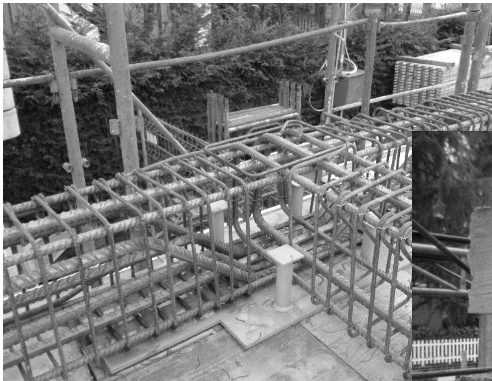
parte superiore degli isolatori prima del getto della soletta del primo piano
