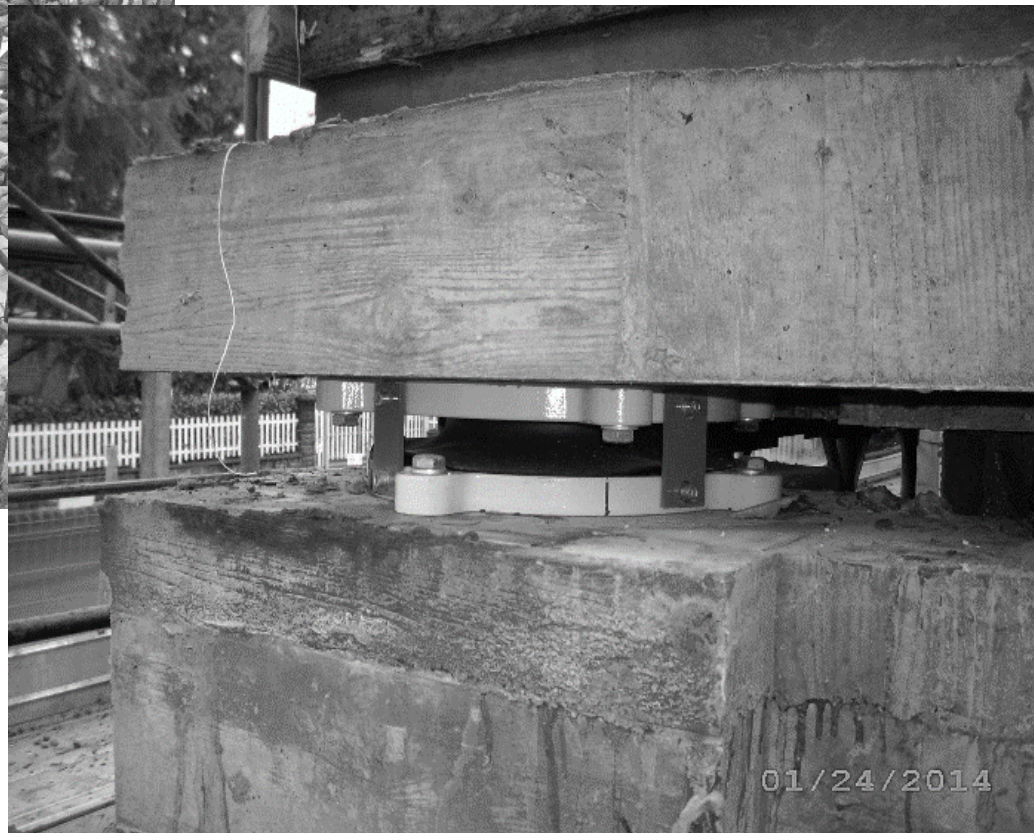
Isolatore posizionato tra muro di cantina e prima soletta
